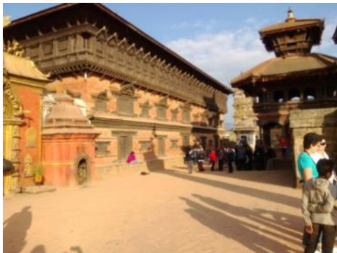
Kungligt slott renoverat enligt traditionell teknik efter 1930. Pagoden fick tyvärr betong i stommen.
